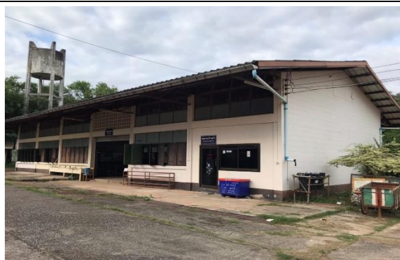
อาคารเรียนแบบเบ็ดเสร็จ ค. ปีที่สร้าง 2536
