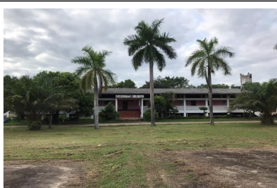
อาคารเรียนเบ็ดเสร็จ ข. ปีที่สร้าง 2536
