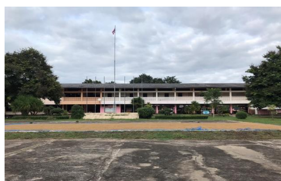
อาคารเรียนเบ็ดเสร็จ ก. ปีที่สร้าง 2536
