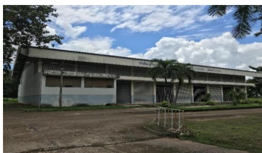
อาคารอเนกประสงค์/โรงอาหาร/โรงฝึกงาน อาคารหอประชุม 100/27 ปีที่สร้าง ๒๕๔๕
