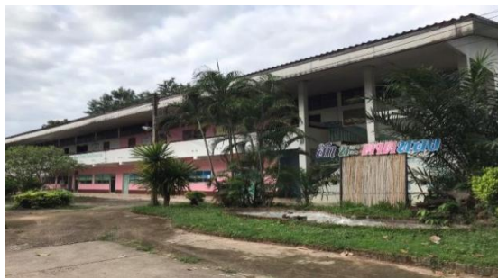
อาคารเรียน ๑๐๘ ล, ๑๐๘ ,ล/๓๐, ๑๐๘ หรือ ๑๐๘ ปีที่สร้าง ๒๕๓๙
