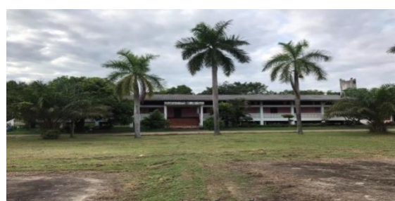
อาคารเรียนเบ็ดเสร็จ ข. ปีที่สร้าง ๒๕๓๖
