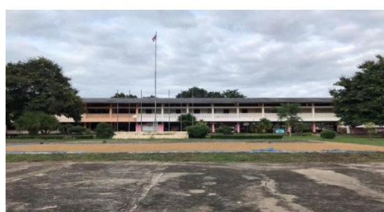
อาคารเรียนเบ็ดเสร็จ ก. ปีที่สร้าง ๒๕๓๖
